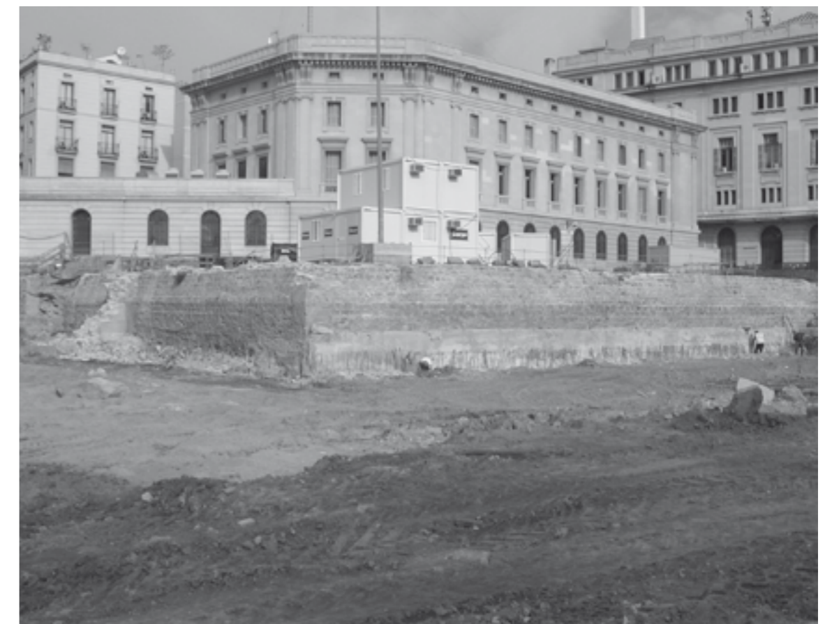
Vista del Baluard de Migdia.
