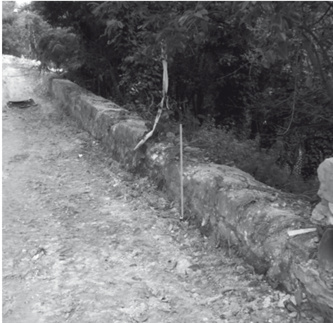
Mur de contenció, d'època moderna, a la carretera Antiga de Montjuïc, a l'inici de les obres.
