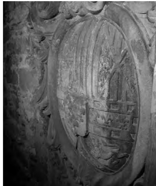
Estat inicial amb els gruixos de crosta negra i carbonatacions a les zones no rentades per l'aigua de pluja.
