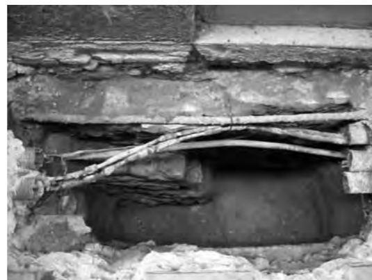
Vista final de la fonamentació de l'edifici.
