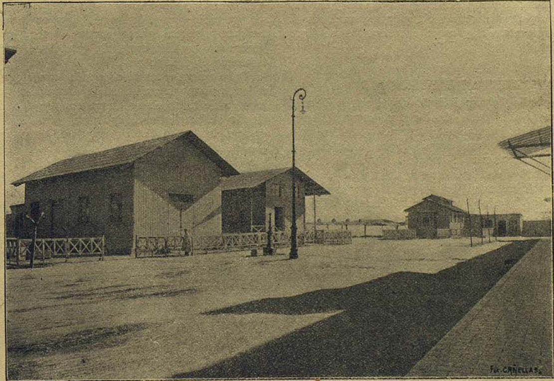
VISTA GENERAL DEL LAZARETO
