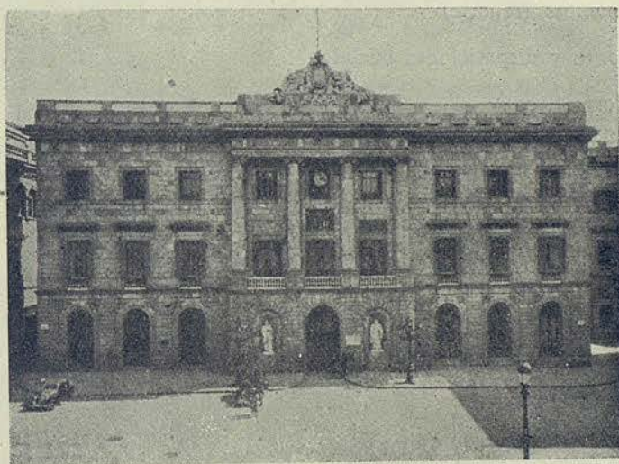
Fachada principal del Ayuntamiento
