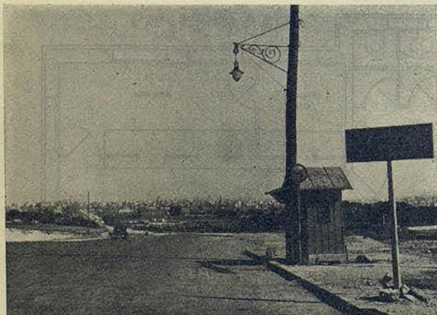
El emplazamiento del Fielato a construir queda aproximadamente a la derecha de la fotografía, junto al poste anunciador
