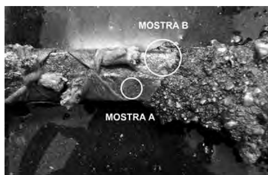
Detall de la zona amb les possibles restes de la beina i les mostres extretes. Foto: Inés Banegas
