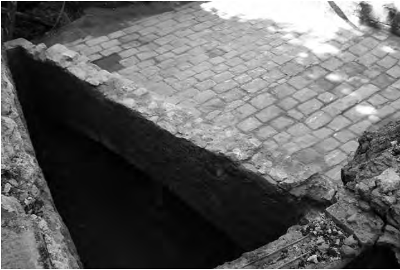
Vista del pont sobre el rec Comtal.
