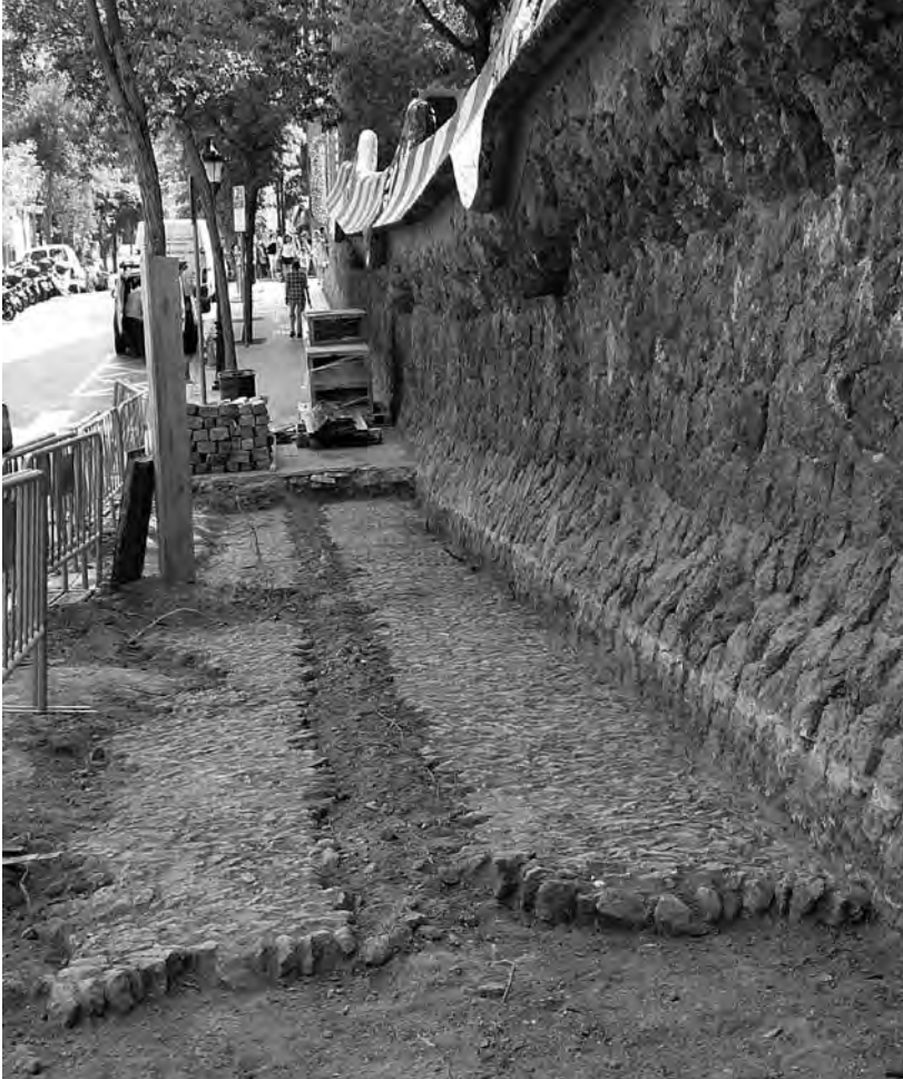
Carrer d'Olot. Paviment de la vorera original de Gaudí. Foto: Anna Bordas
