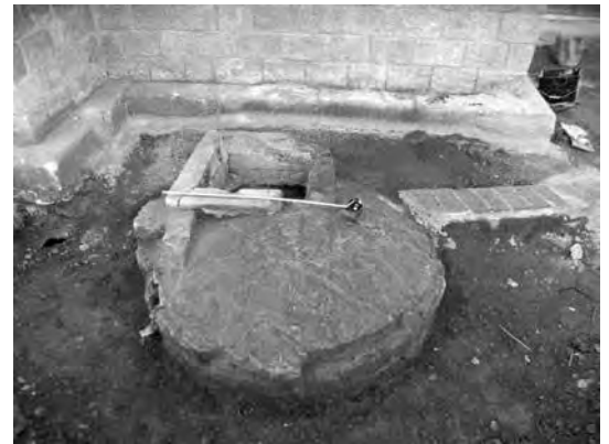
Dipòsit de recollida d'aigües fecals i pluvials. Foto: Òscar de Castro
