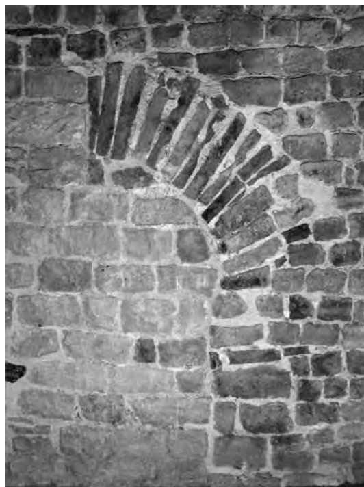
Mur de la torre 28 de la muralla romana després de la intervenció. Foto: Mercè Marquès
