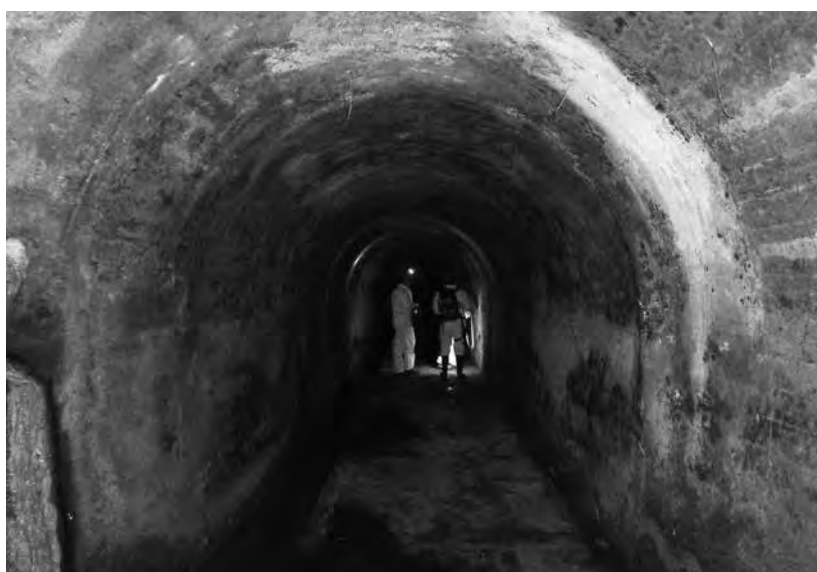
A dalt, carrer de Juan de Sada amb Violant d'Hongria Reina d'Aragó. Un dels accessos al refugi és al subsòl d'aquest edifici.
