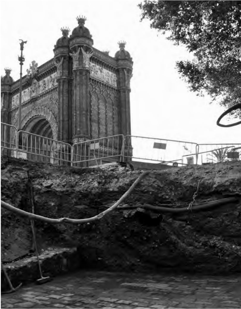
Paviment del pont que creuava el rec Comtal, al passeig de Lluís Companys. Foto: Servei d'Arqueologia de Barcelona
