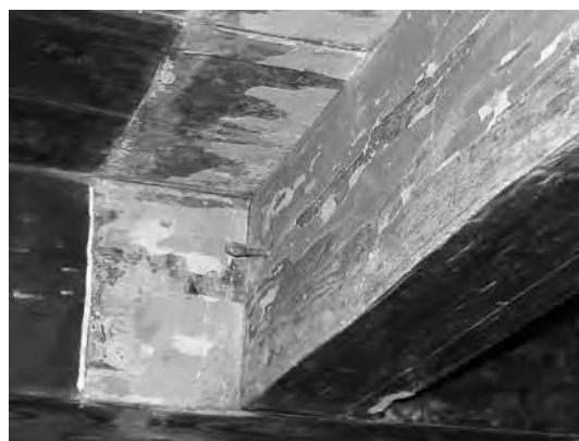
Aspecte de la cara interna de la biga, amb les capes de recobriments. Foto: Raquel García
