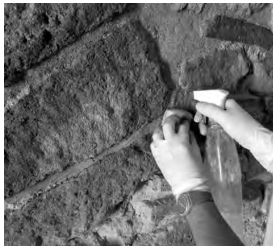
Tractament d'acabat esponjat dels morters reintegrats. Foto: Pau Arroyo
