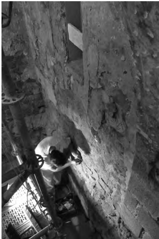
Mur B. Consolidació de les restes de pintura mural. Foto: Mercè Marquès
