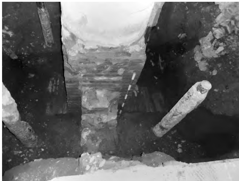
Vista de la riosta i dels arcs de descàrrega d'un dels pilars.
