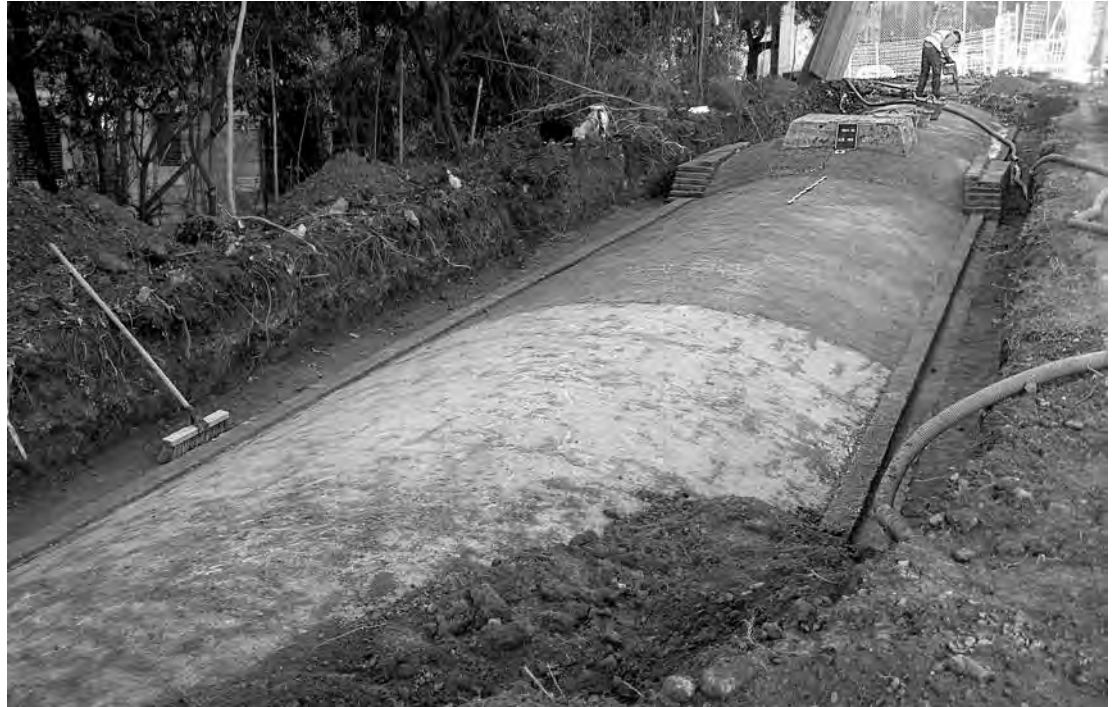
Vista exterior de la volta del túnel.
