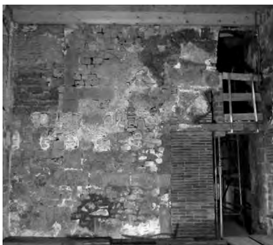
Mur de la muralla romana abans de la restauració. Foto: Mercè Marquès
