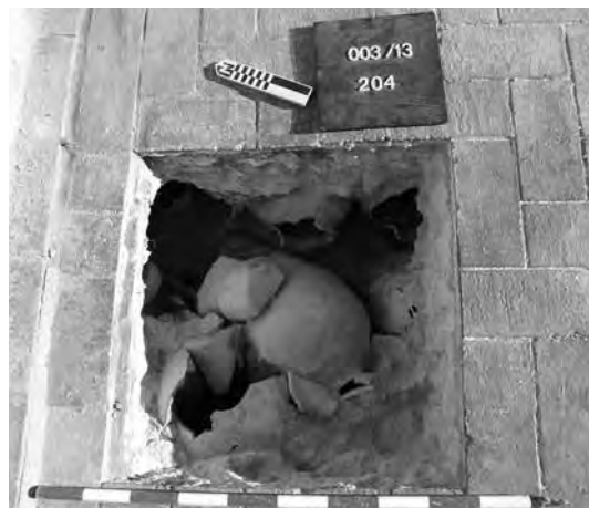
Reblliment de les voltes al sondeig 2.
