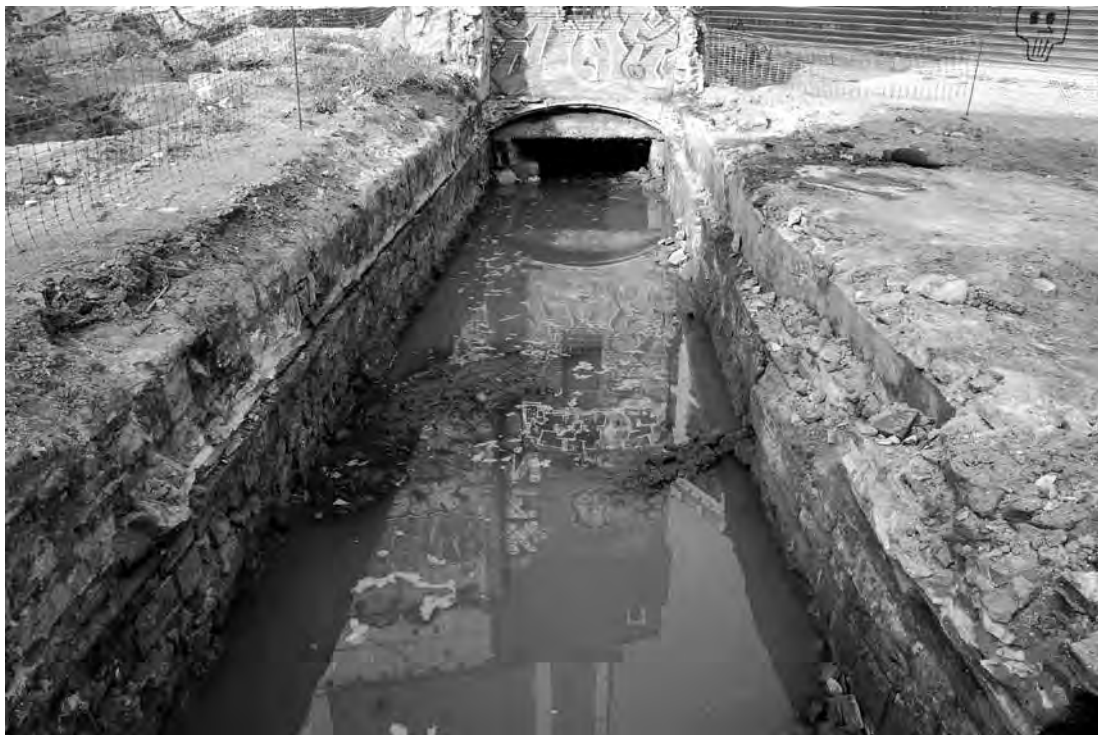
Vista del rec Comtal al seu pas pel solar. En els murs que el delimiten s'observen les restes de la volta que el cobria.
