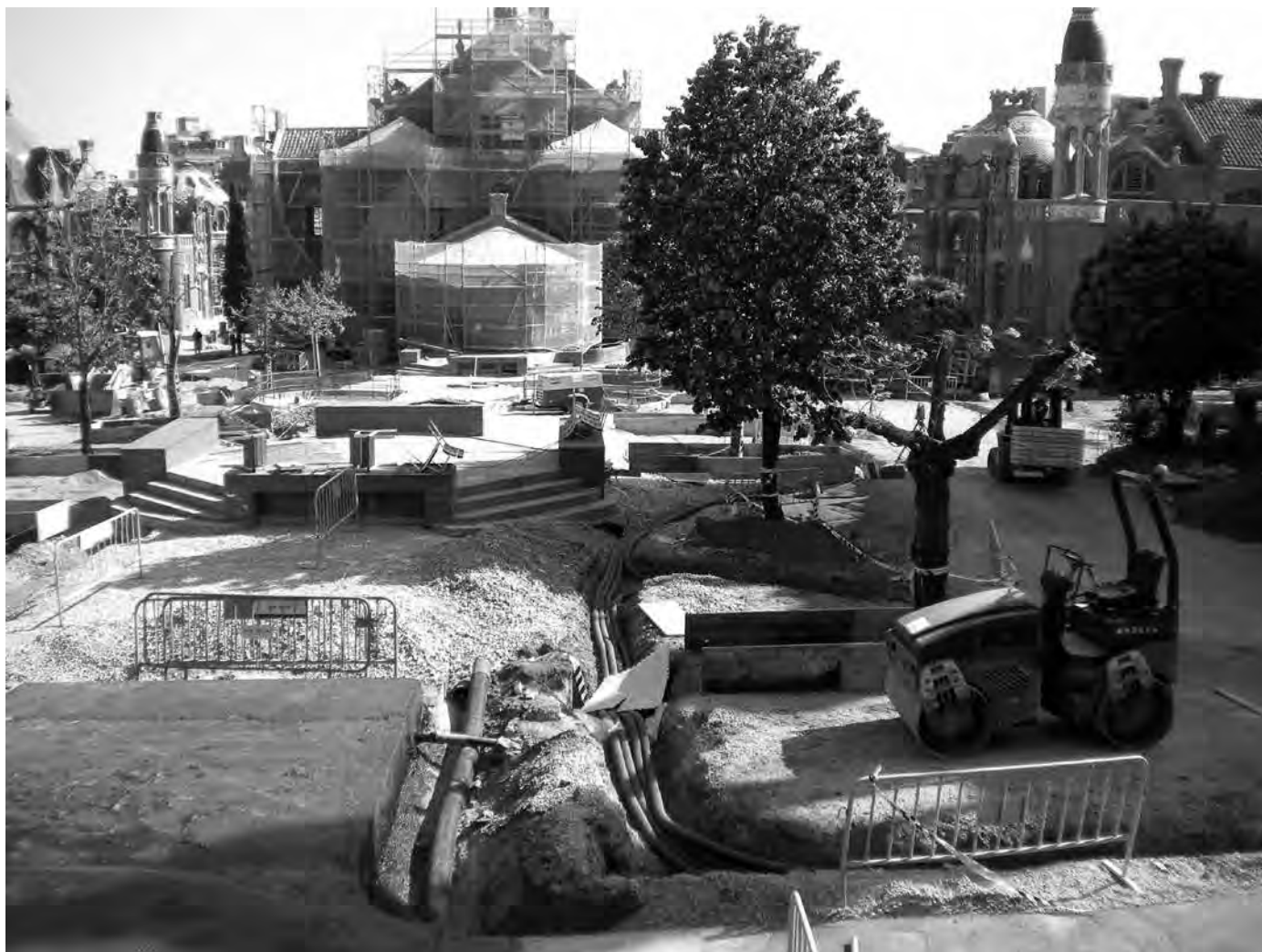
Vista general amb les rases.
