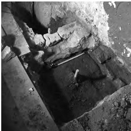
Paviment de llambordes i banqueta del mur de divisió interna.
