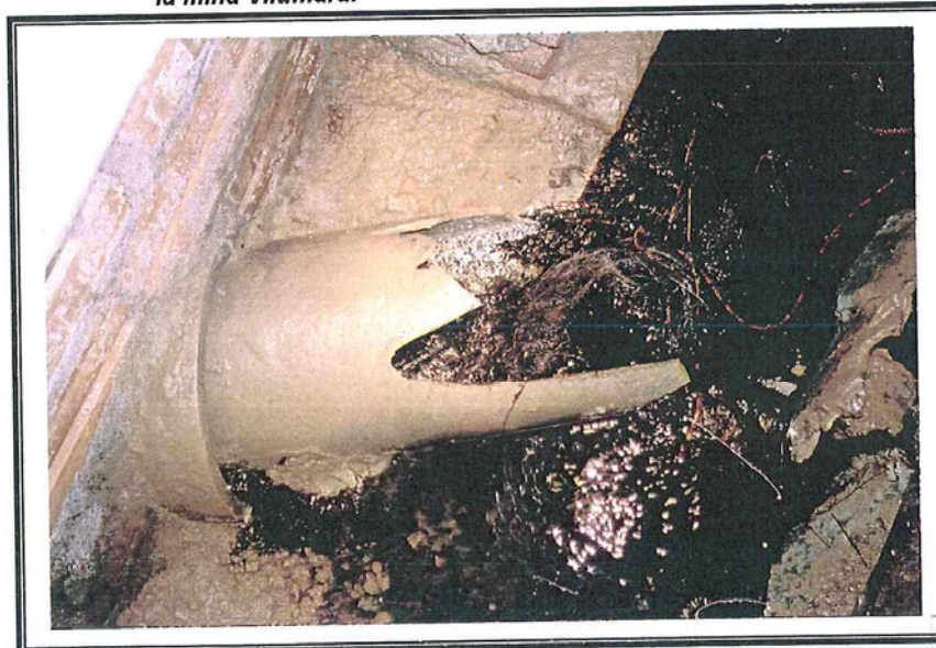
Foto 37 Aspecto de la tubería obstruida por las raíces, antes de limpiarla.
