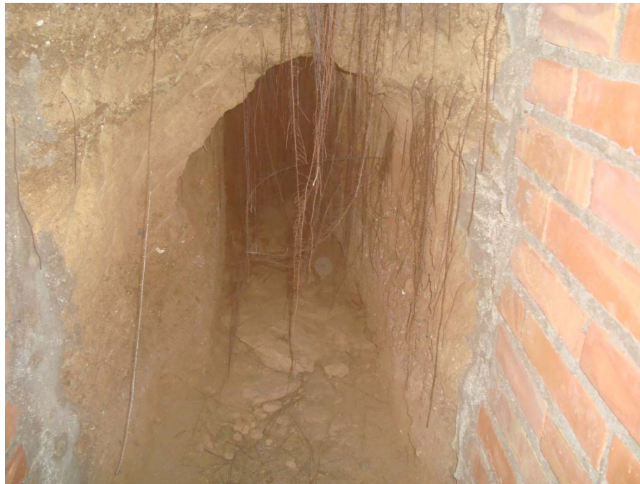
Foto 9. Aspecte de la mina en el punt de connexió a la claveguera.
