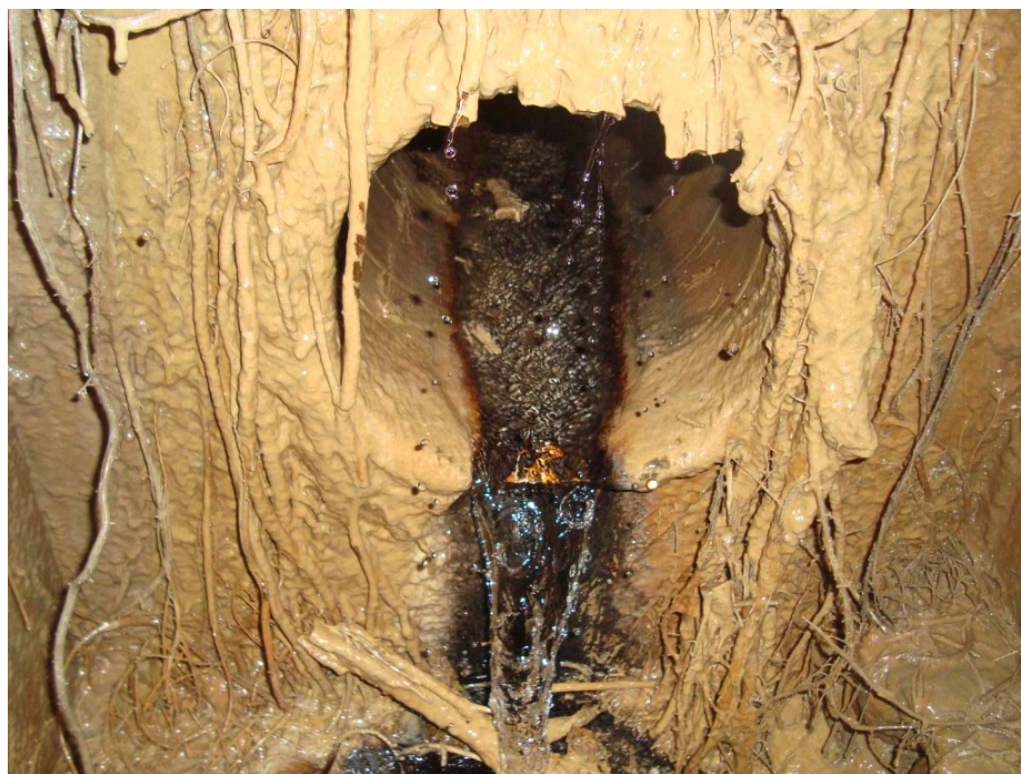
Foto 25. Aspecte del tub un cop retirades les arrels per poder mesurar el cabal.
