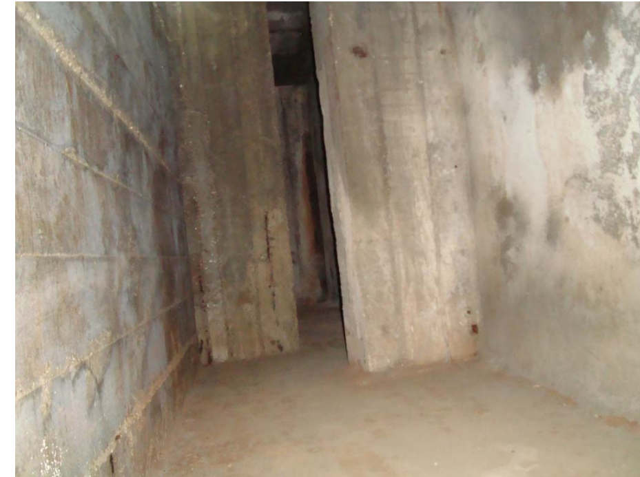
Foto 7. Entre els dos trams d'escales s'observa la cimentació dels edificis.
