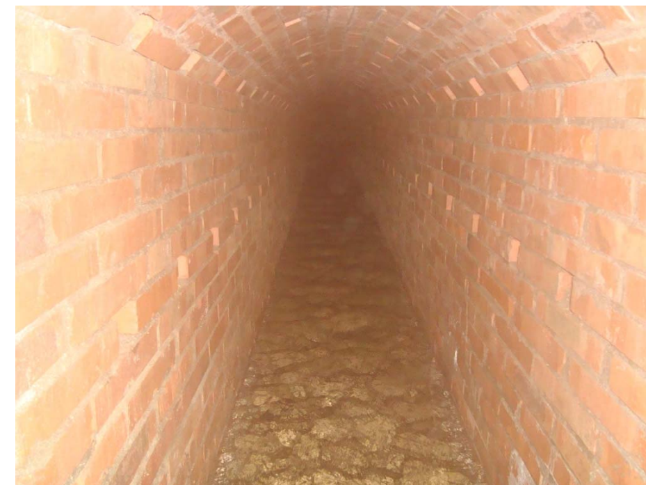
Foto 8. Aspecte de la mina, situada a uns 20 m de profunditat, on es veu circular una làmina d'uns 5 cm d'aigua.
