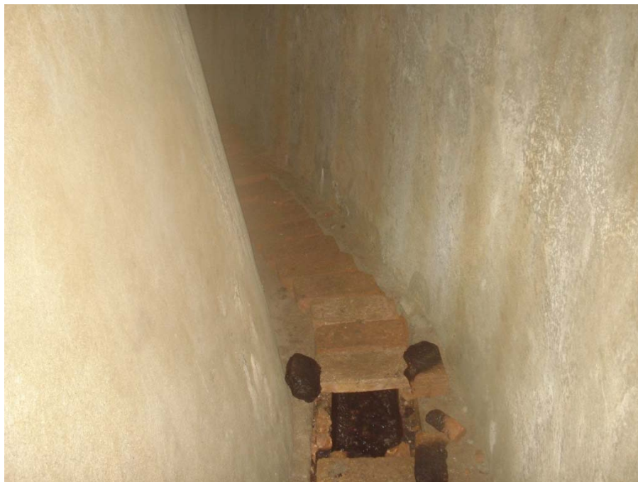
Foto 2. Detall de les lloses d'argila de la solera. Per sota corre l'aigua.
