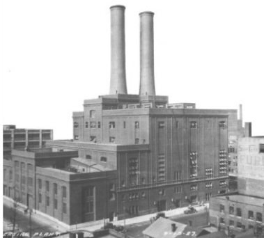
FIGURA 26. PLANTA DE COGENERACIÓ DE DISTRICTE A BEACON STREET, MICHIGAN
