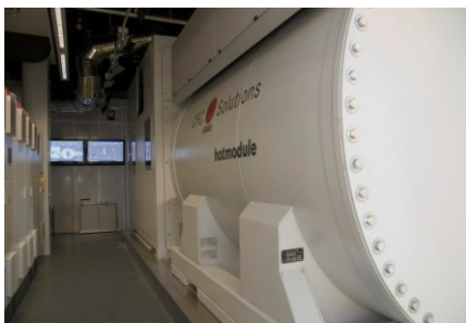
FIGURA 29. PILA DE COMBUSTIBLE DE 200 KW (SEU CORPORATIVA DE GAS NATURAL FENOSA)
