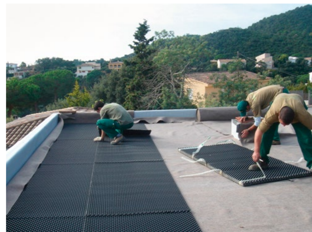
Colocación de placa drenante
