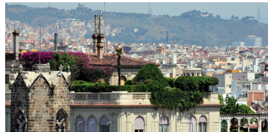
Cubierta privada en Via Laietana
