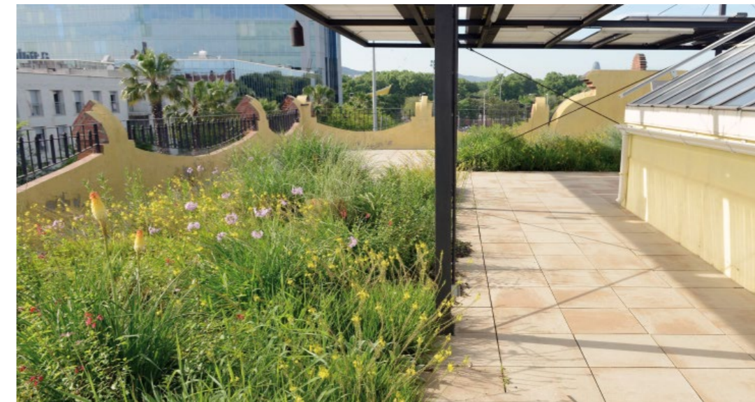
Cubierta verde con aljibe. Fábrica del Sol, p.º Salvat Papasseit, 1
