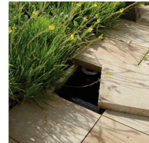
Detalle del aljibe
