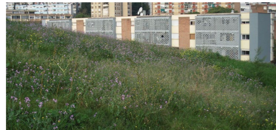
Cubierta de la Biblioteca Zona Nord.
