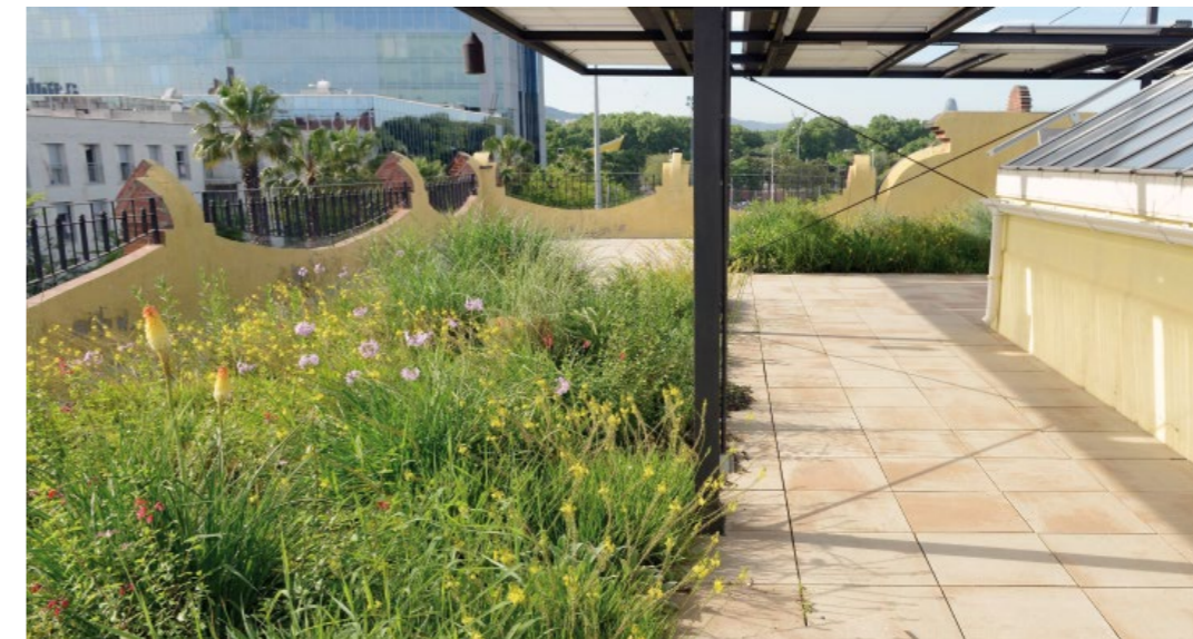
Green roof with cistern. Fábrica del Sol, Pg. Salvat Papasseit, nº 1.
